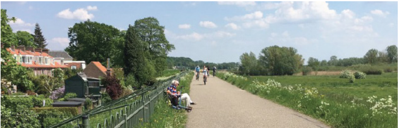
Figuur 2.1.4. - Foto Grebbedijk ter hoogte van Wageningen (bron: LINT)
