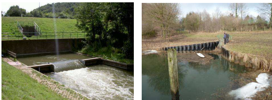
Figuur 9-1: Foto's, links uitlaatgedeelte, rechts inlaatgedeelte [18]
