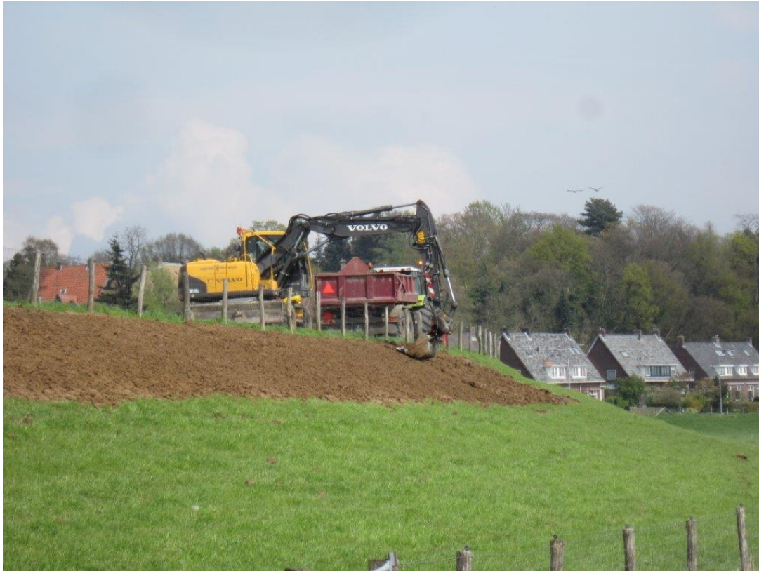
Figuur 3-10 Foto aanvulling buitentalud, aangeleverd WSVV
