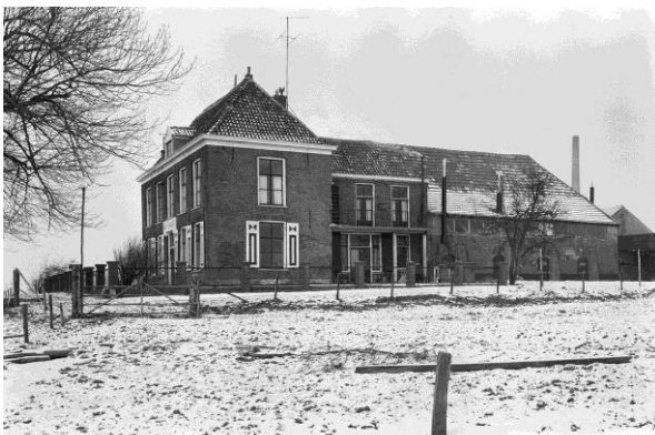
Afbeelding 19 Zijaanzicht boerderij Wolfswaard (datering foto onbekend); op de achtergrond is nog de schoorsteen van de in 1970 gesloopte steenfabriek De Koebongerd te zien. Bron: Rijksdienst voor het Cultureel Erfgoed.
