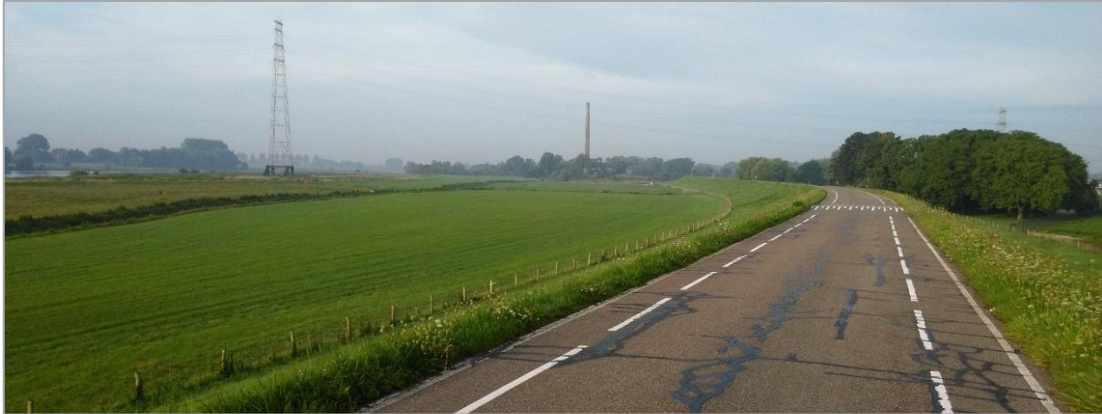
Figuur 2.7 De Grebbedijk ter hoogte van het binnenveld en de Plasserwaard
