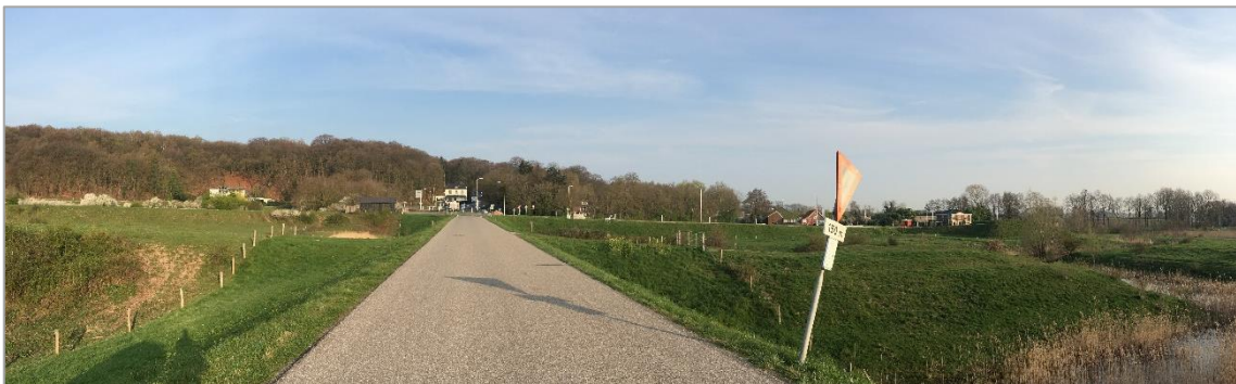
Figuur 2.8 De Grebbedijk bij het Hoornwerk
